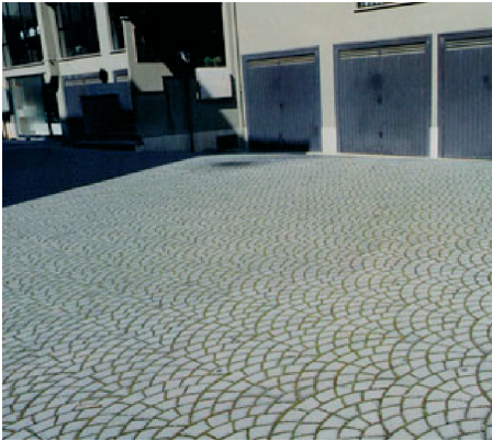
Fig. 1 – Esempi di pavimentazioni realizzate esterne con diversa geometria di tessitura in masselli autobloccanti di calcestruzzo. Si noti il rilevante impatto visivo che le aree pavimentate possono avere quando siano osservate dall'alto.
